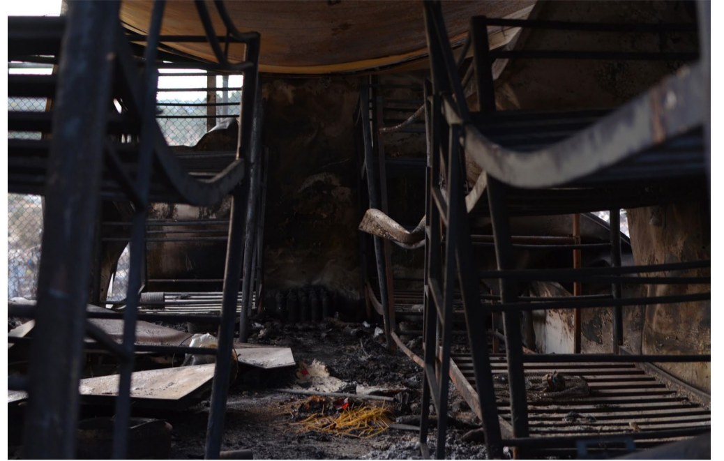
Ausgebrannter Wohncontainer in Moria. (Bild: Privat)
